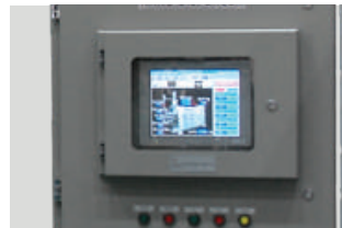
운전 중 설비의 가동상태를 파악할 수 있으며, 경보기능으로 문제발생시 신속한 대응 가능
